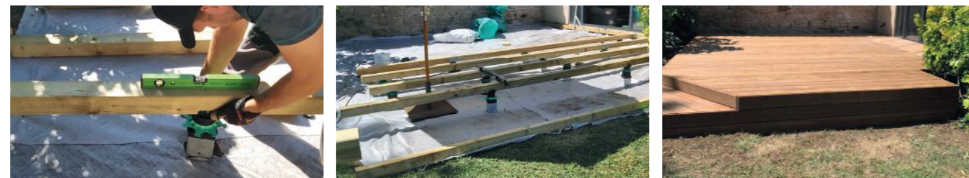
1 Planter les pieux d'ancrage dans le sol puis placer les plots ELEVO® en respectant les entraxes.
